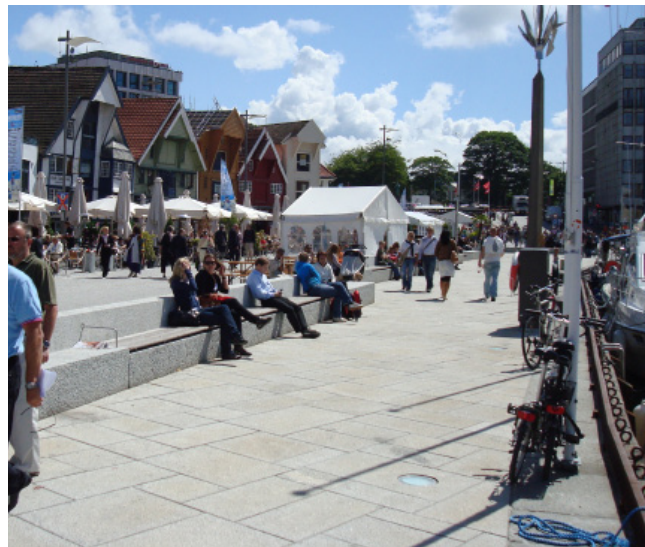
Havnepromenaden i Stavanger, hvor højvandssikring er udført som en integreret del af anlægget.
