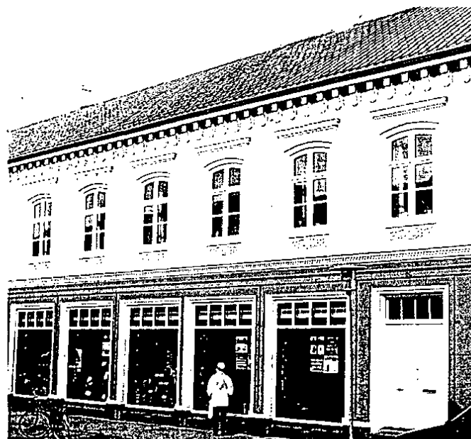
Eksempel på en vellykket renovering af en butiksfacade i Langegade
